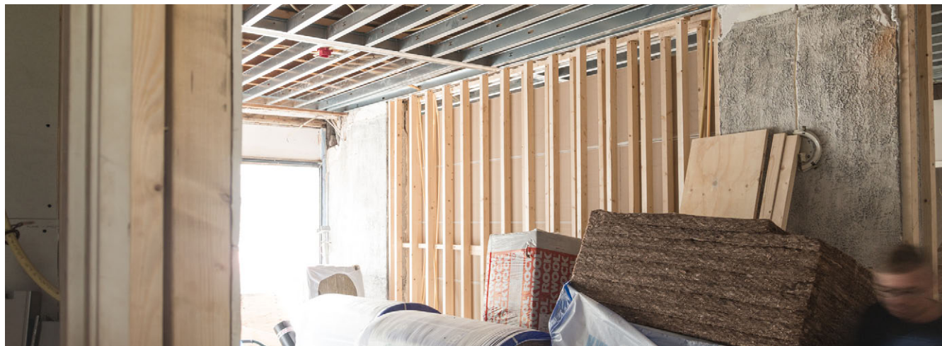
Het interieur van Mathenesserweg 127-129 tijdens de verbouwing
