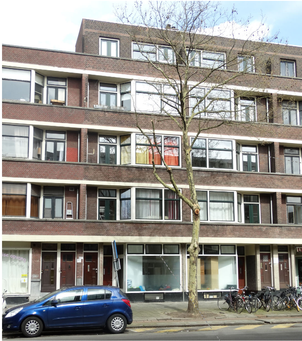
Voorbeeld van de vervanging van kozijnen, waarbij zorgvuldig ontworpen kunststof kozijnen zijn toegepast. Het vervangen van kozijnen in een ander materiaal dan hout is alleen toegestaan bij het vervangen van de hele beuk (dus bij alle boven elkaar gelegen woningen). Hiervoor moet een vergunning worden aangevraagd.
