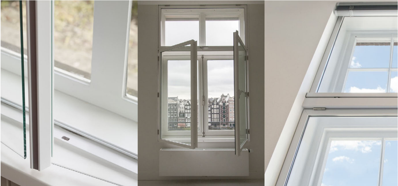
Voorbeeld van de werking van een achterzetraam, waarbij thermische en akoestische isolatie van de kozijnen verbeterd wordt zonder dat het gevelbeeld vanaf de straat verandert.
