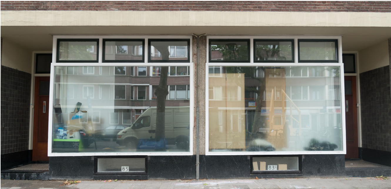
Mathenesserweg 83-85 na de verbouwing
